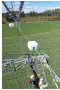
Die Sensorkugel auf dem Leiterseil liefert wertvolle Informationen Quelle: Bayernwerk
