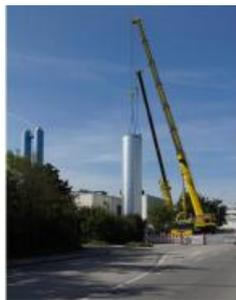
Neben zwei Großwärmepumpen wurde in Poing auch ein 22 Meter hoher Wärmespeicher installiert.
