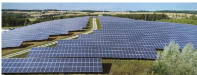
PV-Freiflächenanlage Kirchberg. Quelle: Rhein-Hunsrück-Kreis
