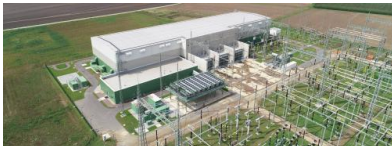
Konverterstation in Niederzier in Nordrhein-Westfalen. Quelle: Amprion
