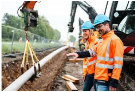
Julie Bürkle-Weiss und Harald Wöfle (beide von Badenova Netze) bei der Absenkung der neuen Wasserstoffleitung Quelle: Badenova / Jonas Conklin
