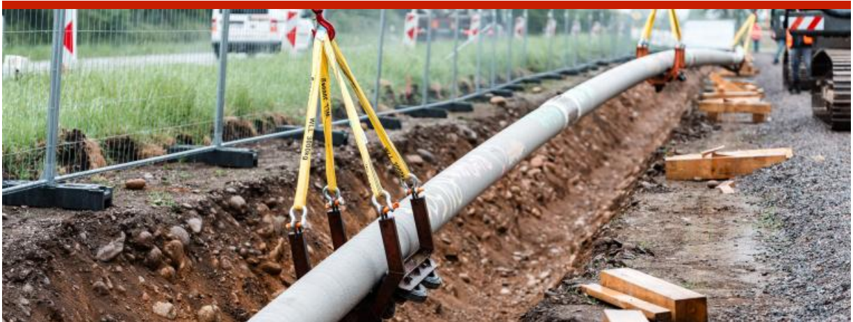
Verlegung der Wasserstoffleitung am Hochrhein. Quelle: Badenova / Jonas Conklin
