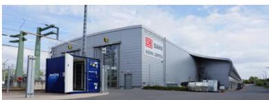
Das ICE-Werk Leipzig kombiniert einen Second-Life-Batteriespeicher mit einer PV-Dachanlage. Quelle: DB / Robert Zimmermann
