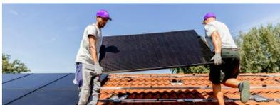
Monteure bei der Installation einer Photovoltaik-Dachanlage. Quelle: 1KOMMA5°
