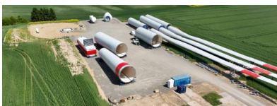
Turm und Rotoblätter des Windparks Dollenkamp vor dem Aufbau. Quelle: Baywa Re
