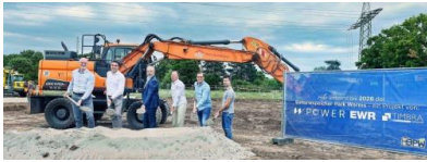
Spatenstich für den Batteriespeicher in Worms. Quelle: EWR
