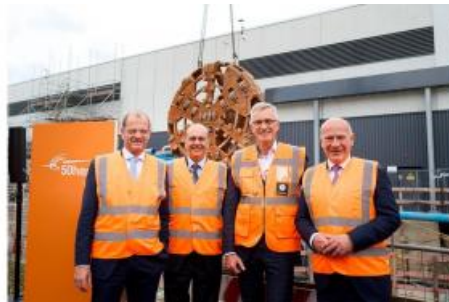
Das Schneidrad (hinten) verlässt den neu gegrabenen Tunnel der Kabeldiagonale Berlin (v.l.n.r.): Stefan Kapferer (CEO 50 Hertz), Bernard Gustin (CEO Elia Group), Henning Schrewe (Head Civil & Special Foundations Implenia Deutschland) und Kai Wegner (Regierender Bürgermeister)
