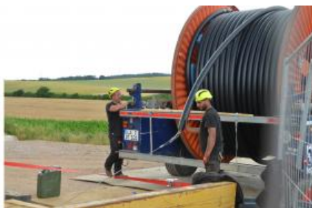
Mit einem Stahlseil wird das Kabel in die Muffengrube und dort in das Leitungsrohr gezogen Quelle: Katia Meyer-Tien
