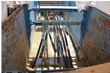
Blick auf die bereits eingezogenen Kabelstränge in der Muffengrube Quelle: Katia Meyer-Tien
