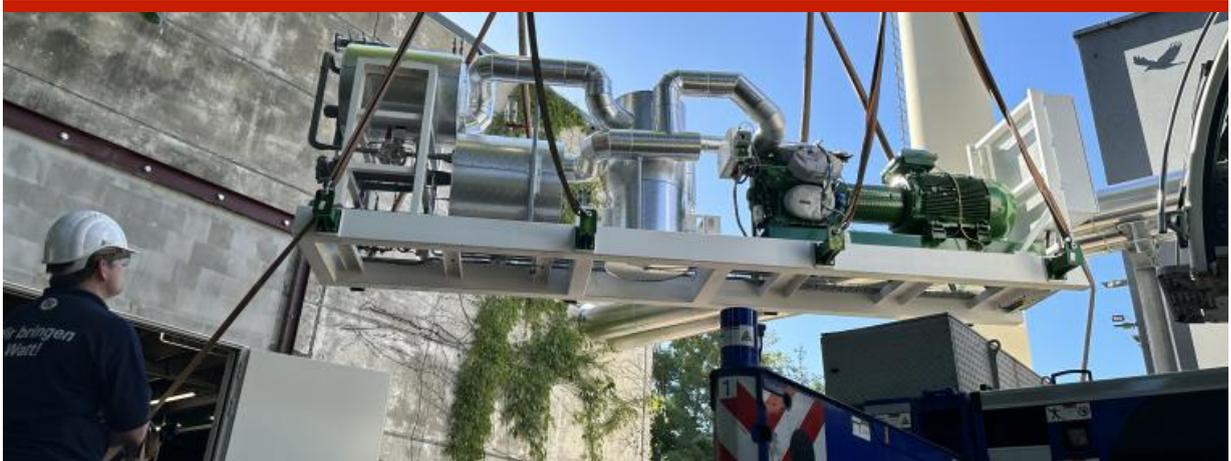
Grüne Wärme kommt per Kran: Die Wärmepumpe von 2G Energy fürs neue Heizsystem in Erkner. Quelle: EWE
