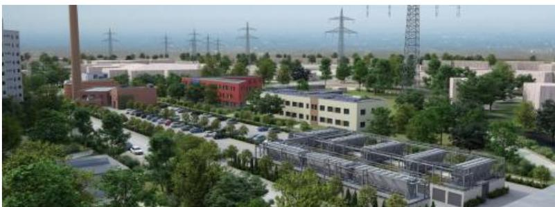
Visualisierung des Heizwerks Bergedorf-West: vorne rechts die künftigen Garagen mit den Luftkühlern. Hinten: Das alte Heizwerk mit dem neuen Wärmepumpengebäude
