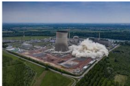
2020 ließ EnBW die beiden Kühltürme in Philippsburg sprengen Quelle: EnBW
