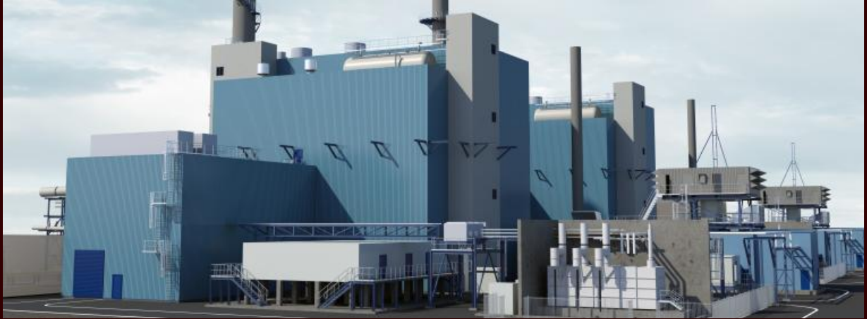
Gaskraftwerk in Marl. Quelle: Evonik
