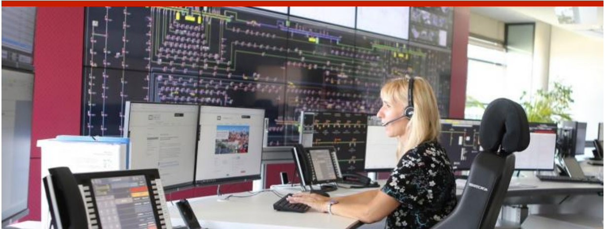
Digitalisierte Leitstelle der SWE Netz in Erfurt. Quelle: SWE Netz GmbH
