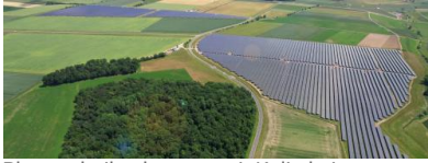
Photovoltaikanlage unweit Koltitzheim, Unterfranken. Quelle: PV Unger
