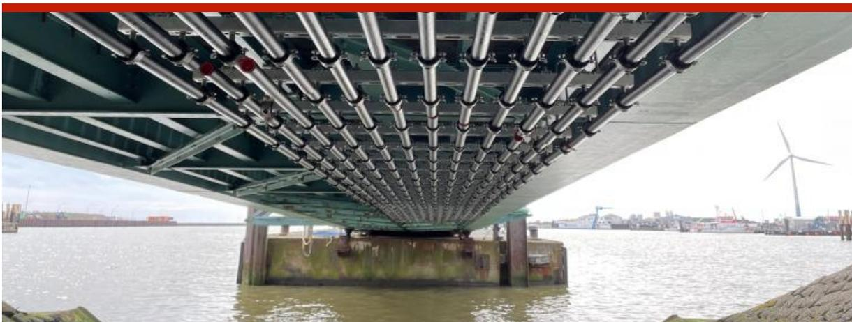
Über Wärmetauscher im Hafen kommt Energie auf die Insel Borkum. Quelle: Kuhr GmbH
