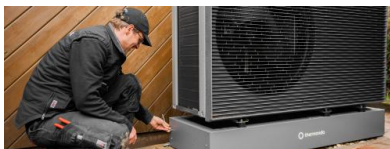
Handwerker bei der Montage einer Wärmepumpe. Quelle: Thermondo
