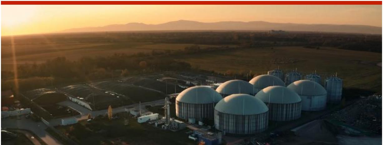
Biogasanlage in Eschbach. Quelle: Badenova / Jonas Conklin
