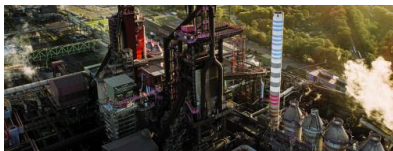
Hochofen des Stahlkonzerns in Duisburg-Hamborn. Quelle: Thyssenkrupp
