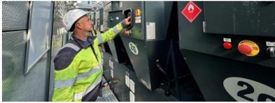
Teil des neuen Heizsystems: Die Luft-Wasser-Wärmepumpe nutzt Außenluft. Quelle: Nadine Auras
