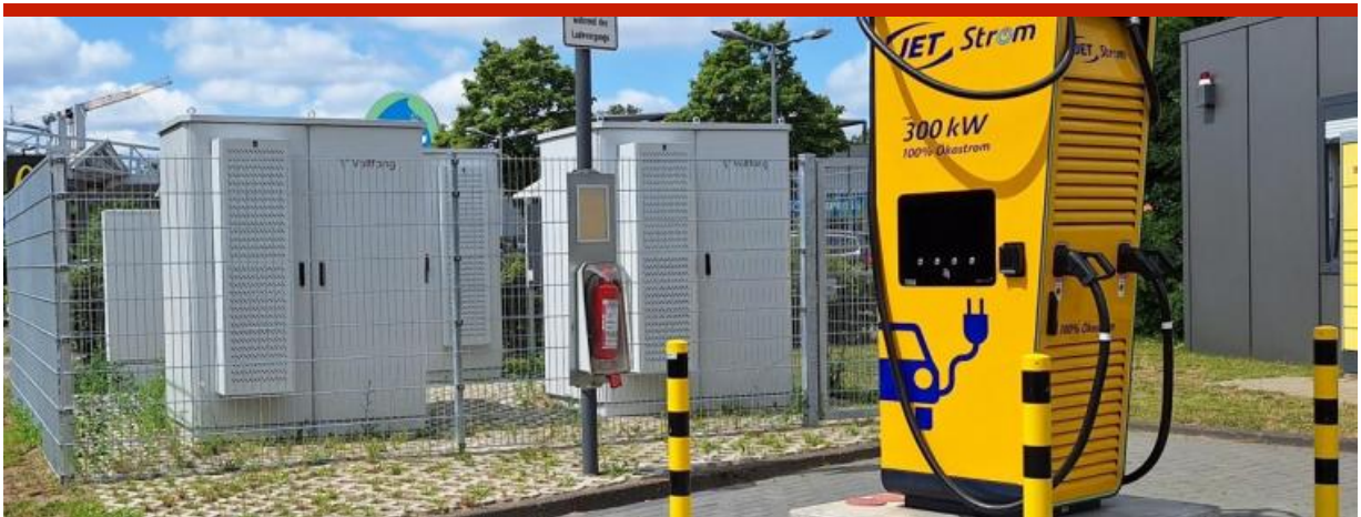
Ein Batteriespeicher speist Jets Schnellladesäule in Hamburg. Quelle: Voltfang
