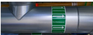
Fernwärmeleitung der Stadtwerke Münster. Quelle: Michael C. Moeller
