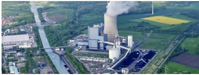
Luftaufnahme des Kraftwerks Datteln 4. Quelle: Uniper SE
