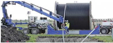
Verlegung von Erdkabeln. Quelle: Tennet
