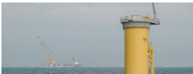
Der letzte Pfahl für Dänemarks Windpark "Thor" ist gesetzt. Quelle: RWE
