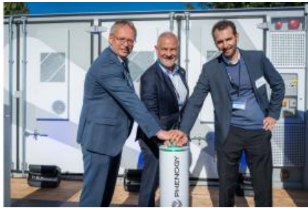
Stefan Thiel (Solares AG), Peter Braun und Max Kory (beide Phenogy AG) bei der Inbetriebnahme der Natrium-Ionen-Batterie in Bremen
