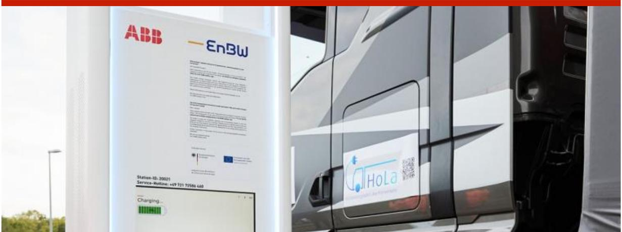
Am Lkw-Megawatt-Ladepunkt an der Rastanlage Lipperland Süd sind Ladeleistungen von bis zu 1,2 MW möglich. Quelle: Mike Abmaier
