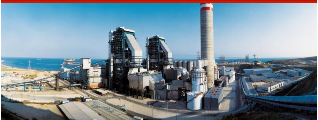
Das Kohlekraftwerk Sugözü. Quelle: Steag Iqony
