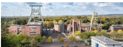
Wird bald ein Batteriespeicherstandort: das Zechengelände Ewald. Quelle: Hertener Stadtwerke / Jan Ahlers
