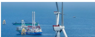
Die DWT ist vor Taiwans Westküste gefragt. Quelle: Hai Long Offshore Wind Project
