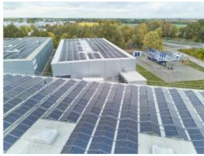
Unsichtbarer Stromproduzent für den Schnellladepark: die 1,7-MW-PV-Anlage auf den nahe gelegenen Hallendächern im Vordergrund. Rechts oben: der Schnellladepark Quelle: EnBW
