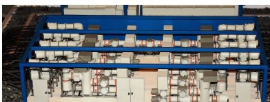
Ein Container-Umspannwerk. Quelle: Günter Drewnitzky
