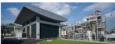
Refhyne 1 ist der Vorgänger des 100-MW-Elektrolyseurs, der derzeit im Industriepark von Shell entsteht. Quelle_Shell Deutschland.jpg
