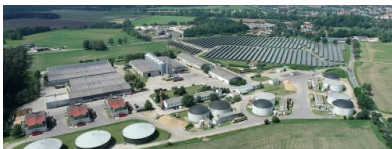
Die Biogas-Produktion Putlitz wird um eine Anlage zur Aufbereitung auf Methanqualität erweitert. Quelle: DAH Gruppe
