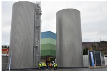
Ein 2.000 Quadratmeter großes Pufferspeichersystem garantiert die Wärmeverfügbarkeit auch bei Spitzenbedarf. Quelle: Getec
