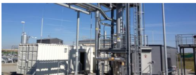
Pilotanlage in Staßfurt (Sachsen-Anhalt) zur Gastrocknung mit keramischen Membranen. Quelle: Fraunhofer IKTS
