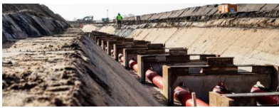
So sieht an Land die offene Bauweise für HGÜ aus. Quelle: Amprion
