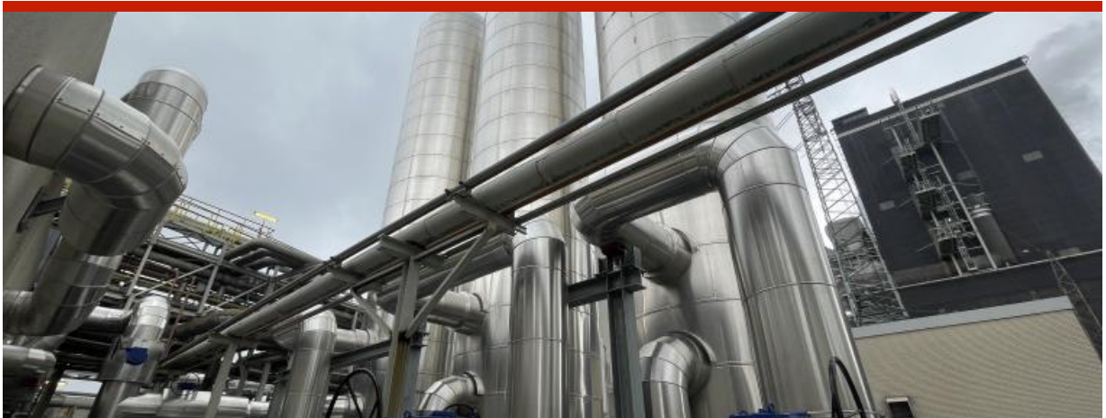
Teil der Anlage: Pufferspeicher beim neuen Pumpenhaus auf dem Gelände des Kraftwerks Scholven. Quelle: Steag Iqony
