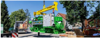
Der Gasmotor für die iKWK-Anlage in Gera-Langenberg wird entladen. Quelle: TEAG
