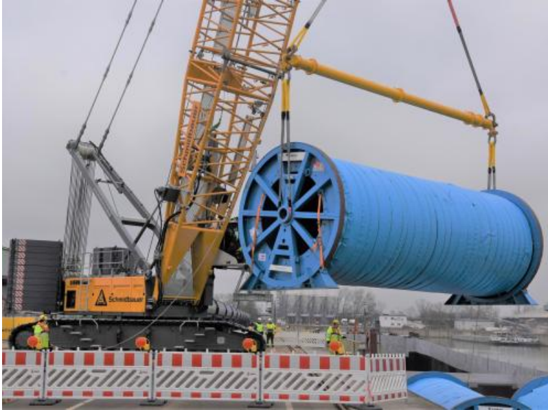
Verladung der Südostlinkkabel im Regensburger Industriehafen. Jede Trommel enthält 1.740 Meter Leitung und wiegt 80 Tonnen Quelle: Günter Drewnitzky
