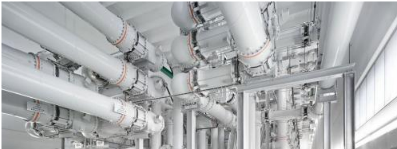
SF 6 -Schaltanlage im Umspannwerk Großgartach in Baden-Württemberg.
