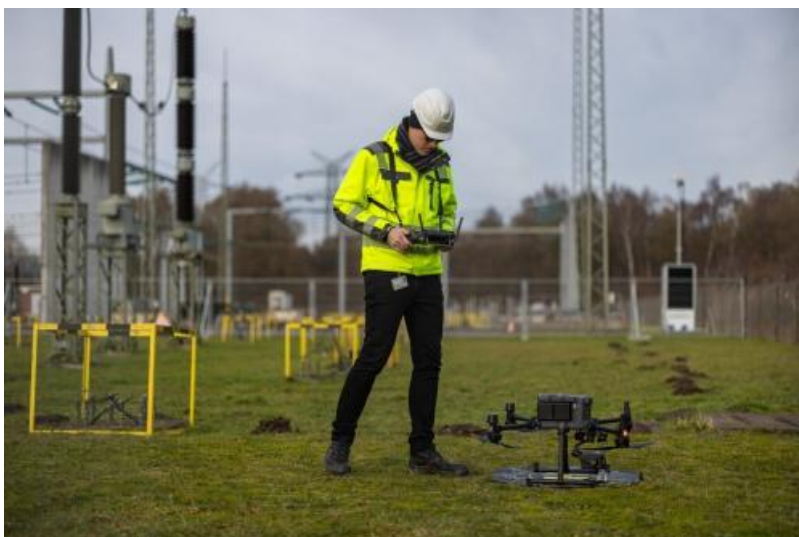
Drohnen können ihre Arbeiten in der Nähe von Anlagen, die in Betrieb sind, ausführen, ohne dass dabei Stromleitungen abgeschaltet
