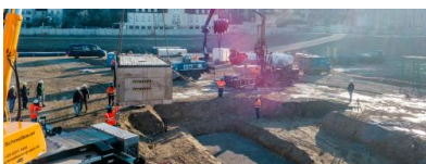
Der Wärmeverteiler für die Martinshöfe wird eingebaut. Quelle: TWS
