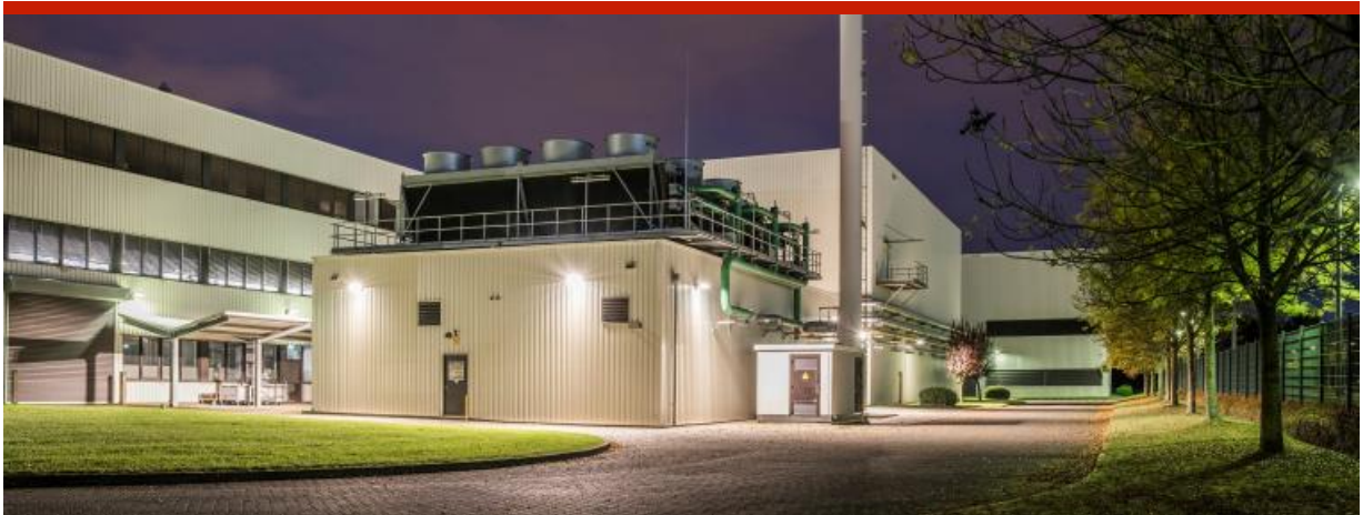
Die neue Kältezentrale von Toyota. Quelle: Rheinenergie / Maurice Volmeyer
