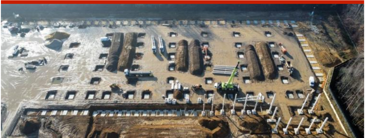
Die Baustelle des Gewerbekomplexes in Kerkrade. Quelle: Panattoni
