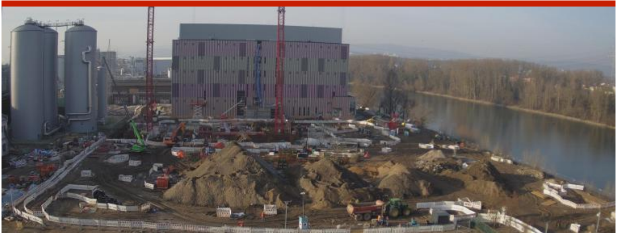
Das Kraftwerksgelände auf der Ingelheimer Aue. Quelle: Kraftwerke Mainz-Wiesbaden AG
