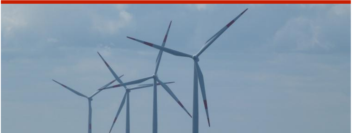
Offshore-Windpark in der Nordsee. Quelle: Hereon_Ina Frings
