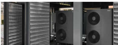
Skalierbare Wärmepumpenkaskade des Typs "Energy 2.0". Quelle: Vaillant
