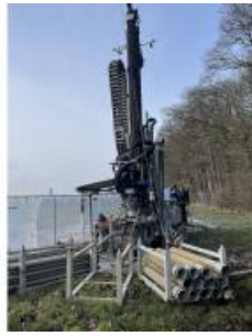
Rund 10 Meter ragt der Bohrturm in die Höhe: Für das kalte Nahwärmenetz in Albachten-Ost bohren die Stadtwerke Münster in rund 250 Metern nach Erdwärme Foto: Baugrund Süd
