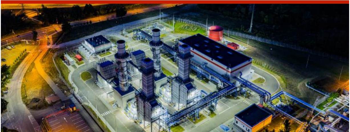
KWK-Anlage in Poznan. Quelle: Veolia
