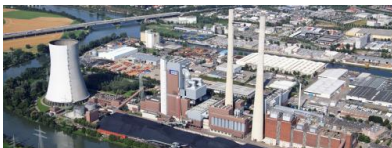
Block 7 des Kohlekraftwerks Heilbronn, rechts neben dem Kühlturm, geht in die Netzreserve. Quelle: EnBW / Daniel Maier-Gerber
