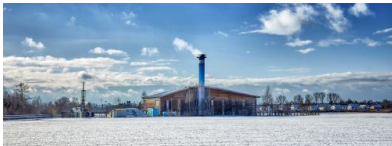
Die EWG-Heizzentrale. Quelle: EWG
