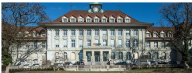
Der Hauptsitz der BKW Energie AG in Bern. Quelle: BKW
