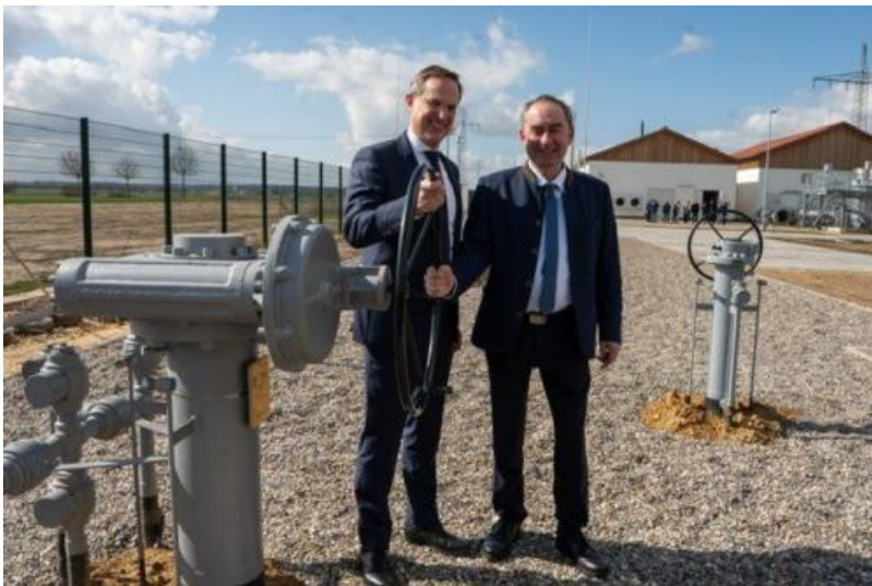
Hubert Aiwanger (r.) und Bayernets-Geschäftsführer Matthias Jenn bei der offiziellen Inbetriebnahme der Gastransportleitung Augusta.
